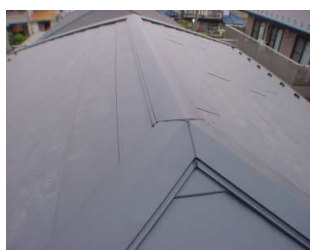
ガルバ断熱ルーフでカバー工法
